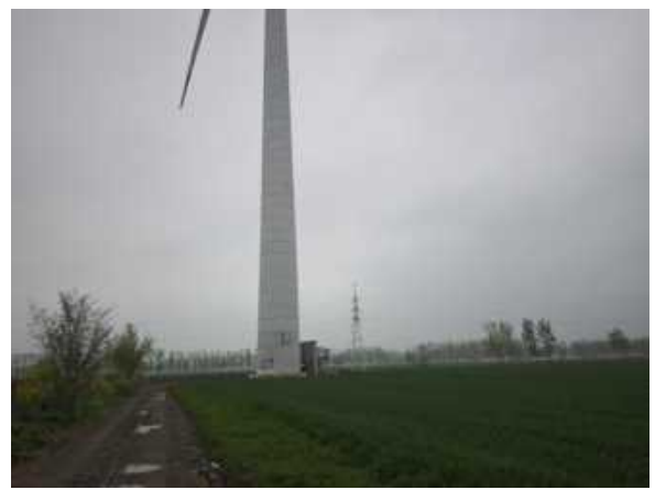
风电场风机土地平整、植被恢复
