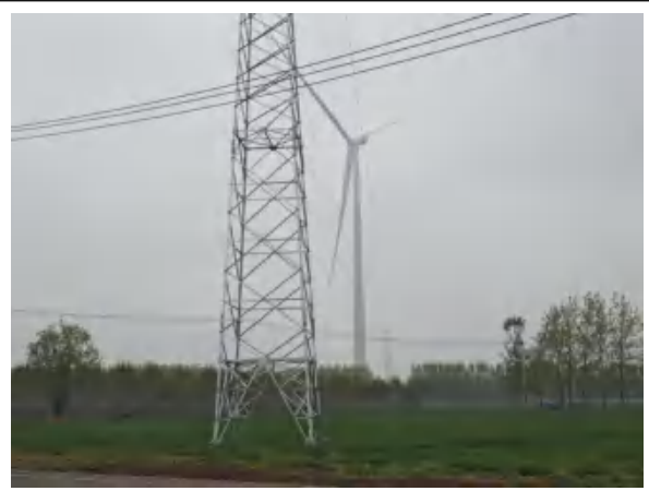
风电场输电线路土地平整、植被恢复
