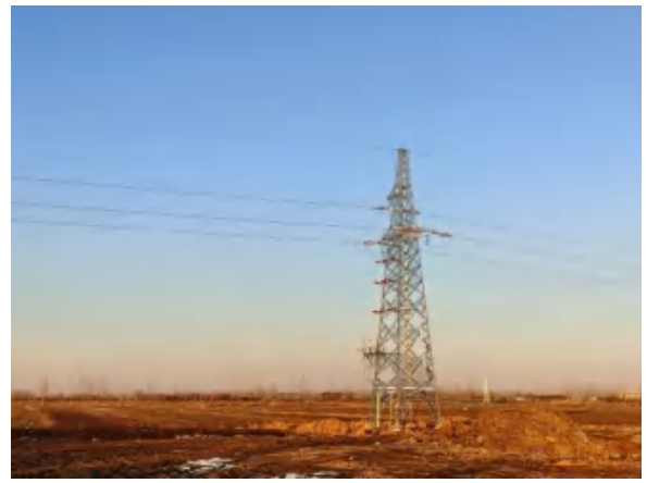
风电场输电线路土地平整、植被恢复
