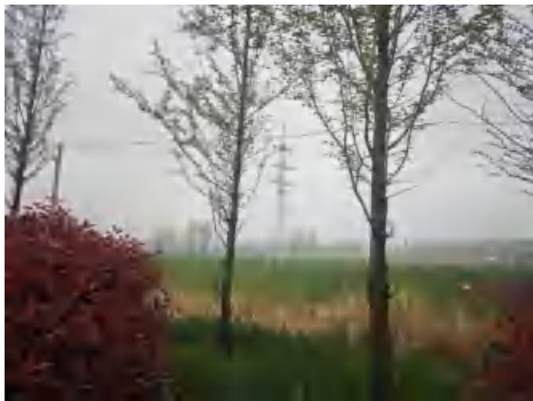
风电场输电线路土地平整、植被恢复
