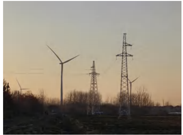
风电场输电线路土地平整、植被恢复
