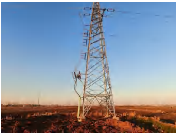
风电场输电线路土地平整、植被恢复
