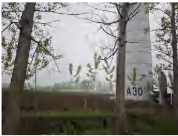
风电场风机土地平整、植被恢复
