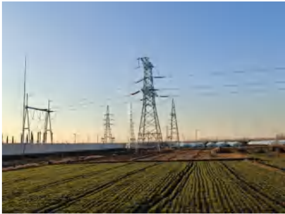
风电场输电线路土地平整、植被恢复
